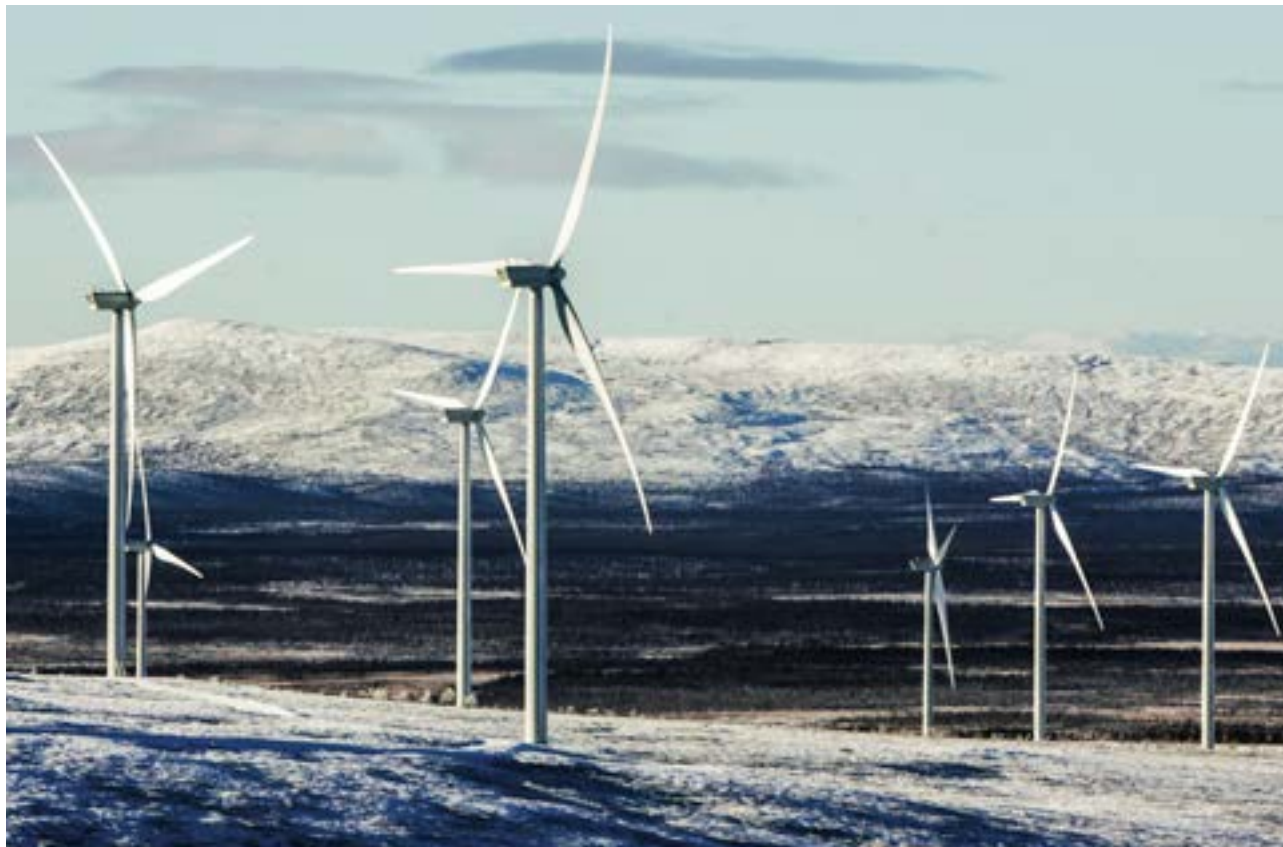
Sjisjka vindpark med 30 vindkraftverk (78 MW) ägs av Skanska, OX2 och Jämtkraft. Foto: Kenneth Paulsson.
