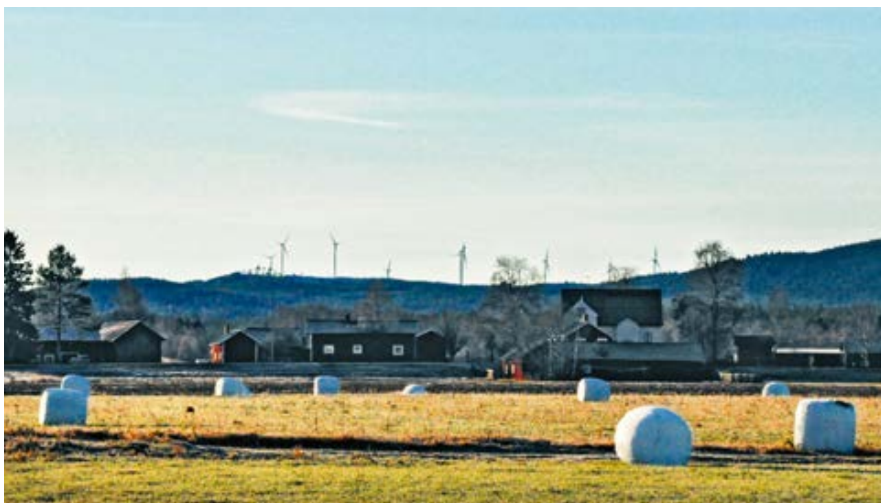
Korpjällets vindpark med nio vindkraftverk (20,7 MW).
