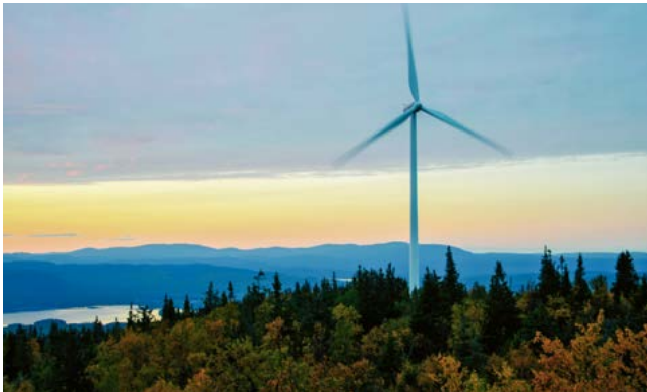
Skymning i Bleikevare vindpark med totalt 18 vindkraftverk (36 MW).
