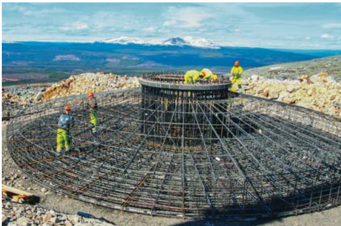
Armering av vindkraftsfundament på Glötesvålen, Härjedalens kommun.
